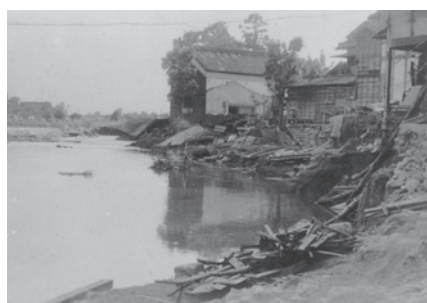
▲地面が大きく削り取られ家屋が倒壊しました(現在の若葉町付近の被害状況)
