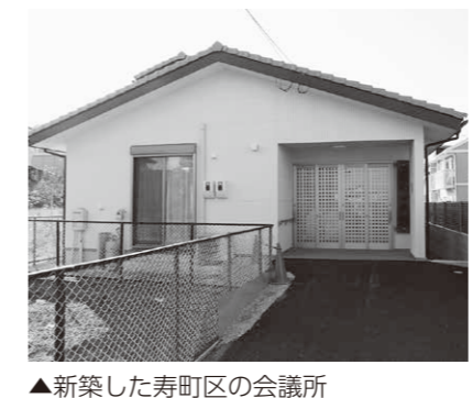
▲新築した寿町区の会議所
