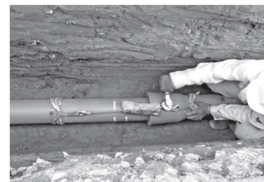
▲老朽化した水道管を更新している様子
