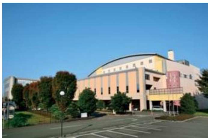
図 6-6 清掃リサイクルセンター21
