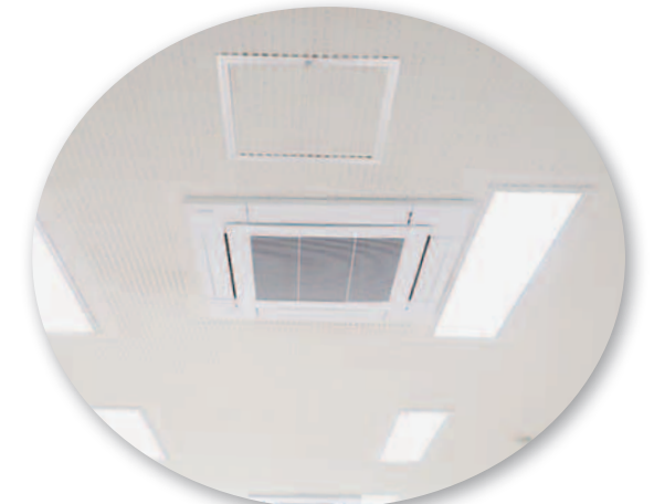
空調機更新 (宮郷中学校)
