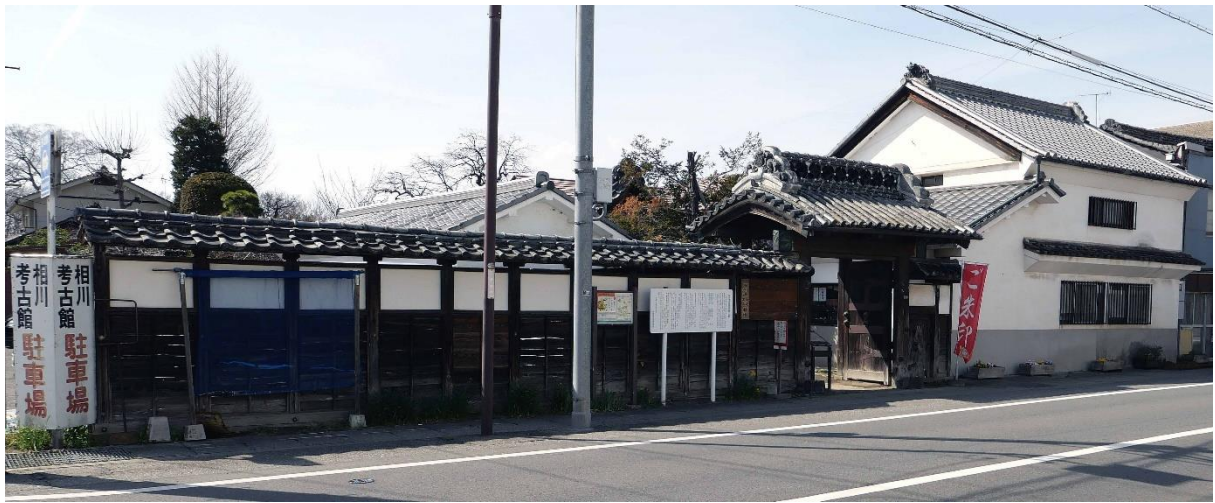
旧相川家住宅表門及び堀 全景（右側は旧店舗）
