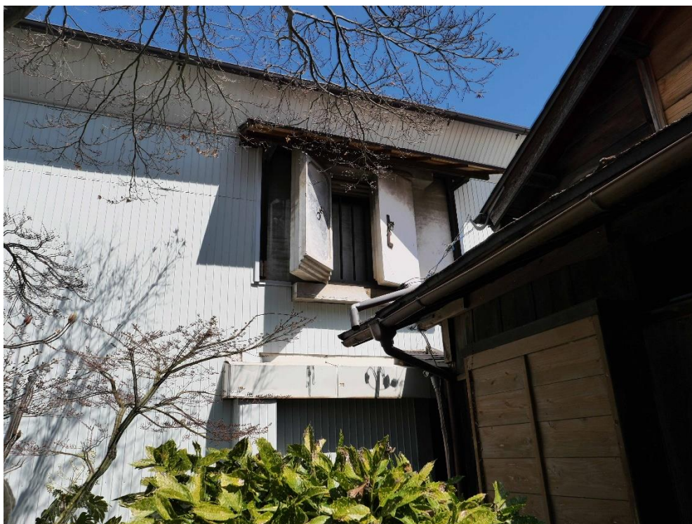
旧相川家住宅土蔵 外観
