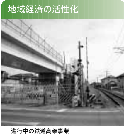
進行中の鉄道高架事業
