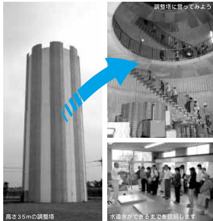
高さ35mの調整塔
