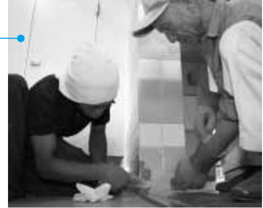
トイレの壁を修繕
