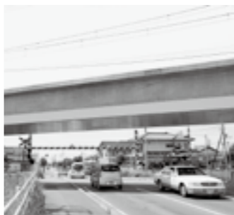
高架による踏切解消で、通行がスムーズになりました。
