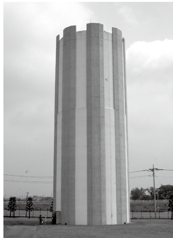
▶竜宮浄水場にある、水道水の圧力を一定に保つ調整塔。地上35メートルの高さで建設されています。
