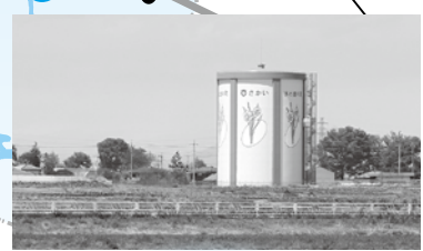
▲境ふちな配水場
