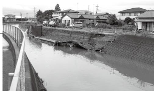
▲増水した大川で崩落した護岸(連取町)
