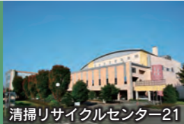
清掃リサイクルセンター21
