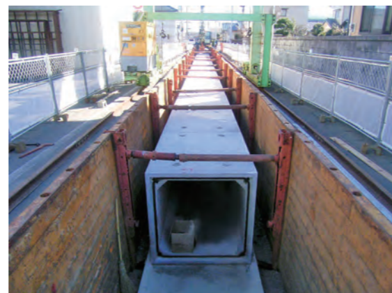
▲工事中の様子
