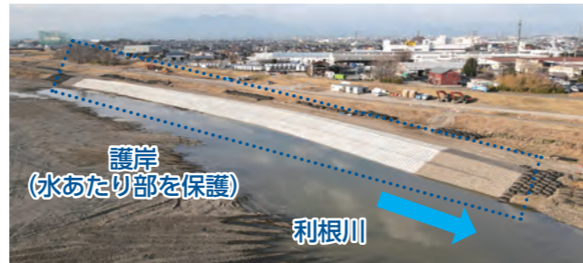
提供：利根川上流河川事務所
