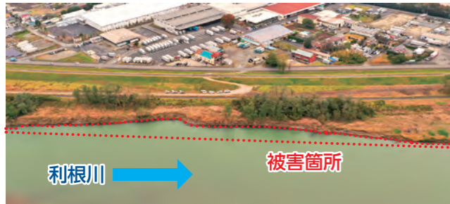
提供：利根川上流河川事務所
