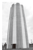
▲竜宮浄水場調整塔
