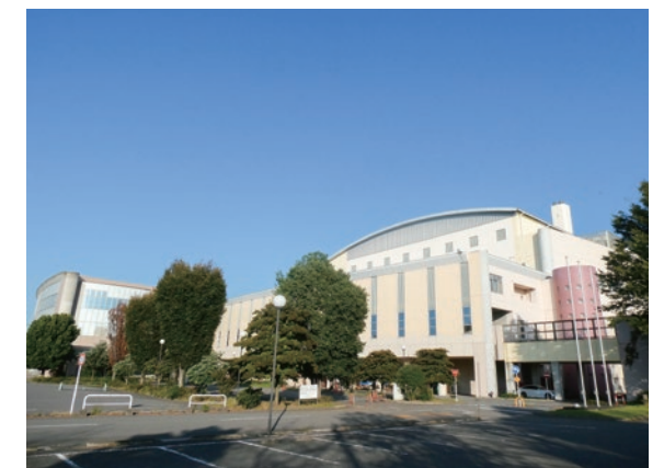
▲既存施設の例 清掃リサイクルセンター21(焼却・資源化施設)
