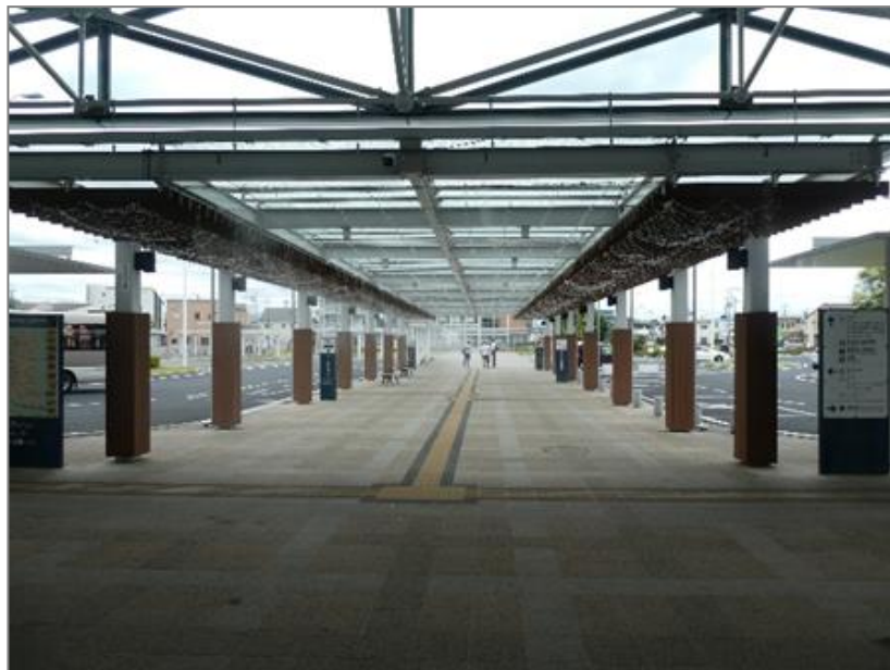
▲令和4年7月 仮設ミスト装置設置時
