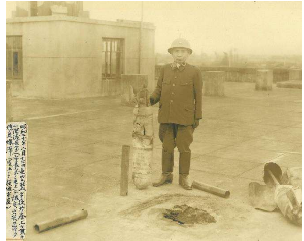
伊勢崎市役所屋上に投下された焼夷弾をもつ板垣源四郎市長
