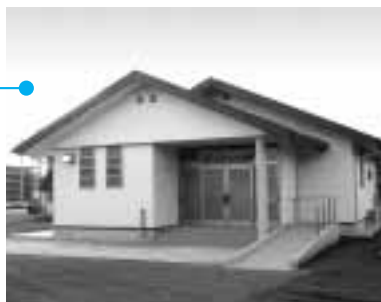
新築された間野谷町区公民館
