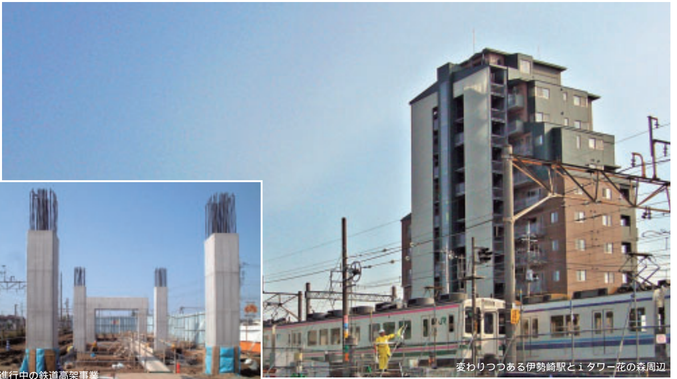
進行中の鉄道高架事業
