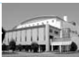
▲ 清掃リサイクルセンター21
