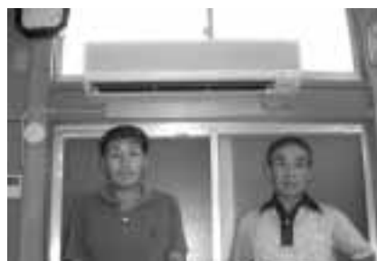
▲ 設置されたエアコン（香林町一丁目区）
