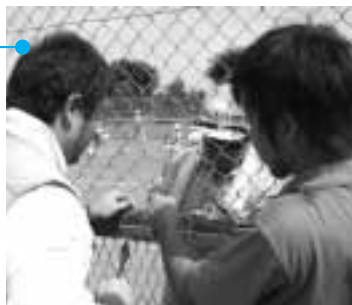
▲ フェンスの修繕をする職人ら
