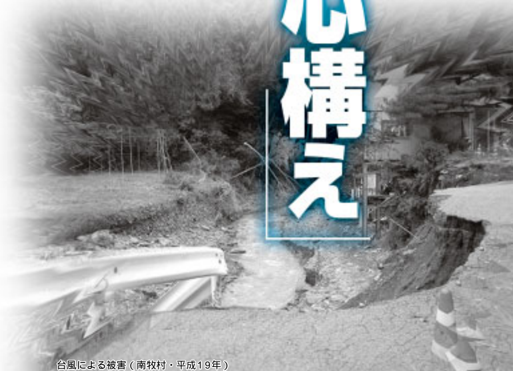
台風による被害(南牧村・平成19年)
