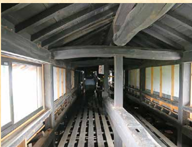
▲1日限定で一般公開された進水館のやぐら内部
