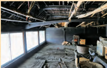
▼屋根裏の様子。窓から光と風を取り入れて養蚕を行っていた。
