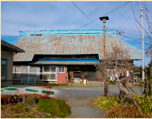
▲波志江町に残る赤城型民家。建築年代は19世紀初めと推定される。屋根はトタンで覆われているが、かつては麦わらで、昭和15年(1940年)ごろまではかやで覆われていたという。田島弥平が考えた瓦ぶきでやぐらのある建物が広まる以前は、養蚕のための建物は草ぶきや板ぶきの屋根が一般的だった。
