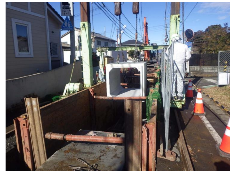
浸水対策工事 一例 (BOX 1100×1100)
