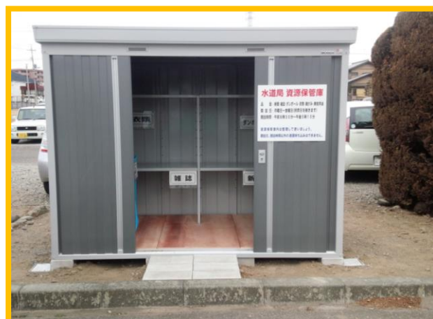
上下水道局(伊勢崎地区)
