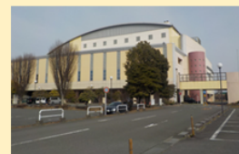
清掃リサイクルセンター21
