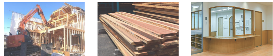
解体 → 製材 → 再利用
