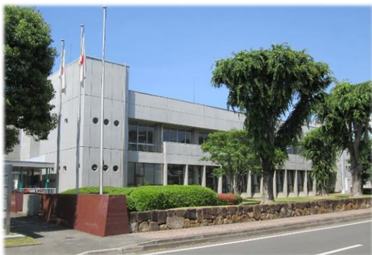
赤堀支所庁舎
