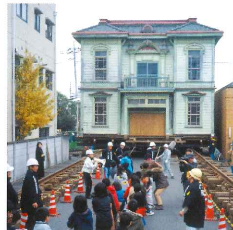
平成14年11月の曳き家移転の様子
