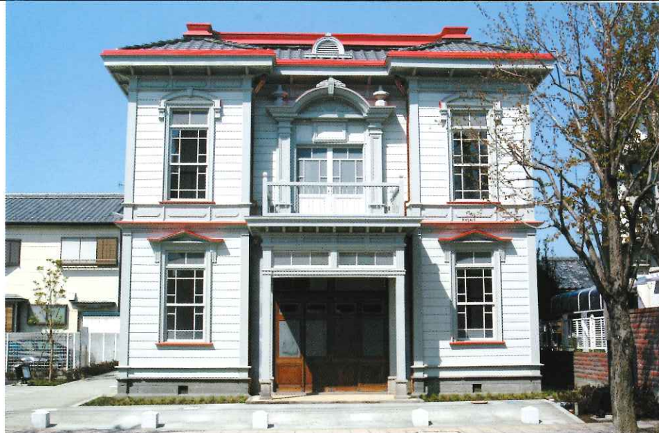
東側正面外観
