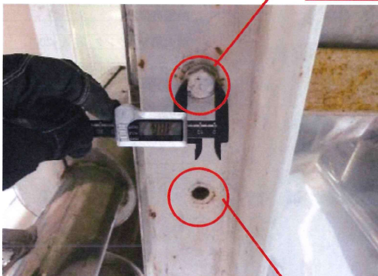
高架水槽取り付けボルト
