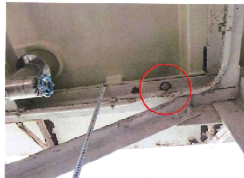
赤マークのボルトは高架水槽固定ボルト 赤マーク横の穴は改修前の固定ボルト孔
