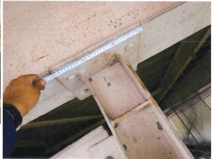
東柱ベースプレートサイズ測定状況
