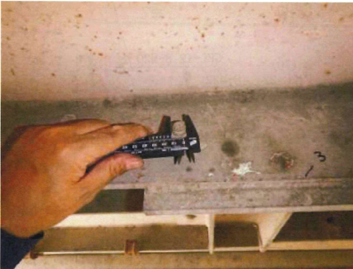
ボルト径測定状況
