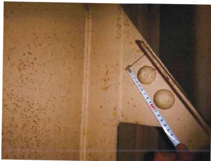
ブレースボルトピッチ測定状況
