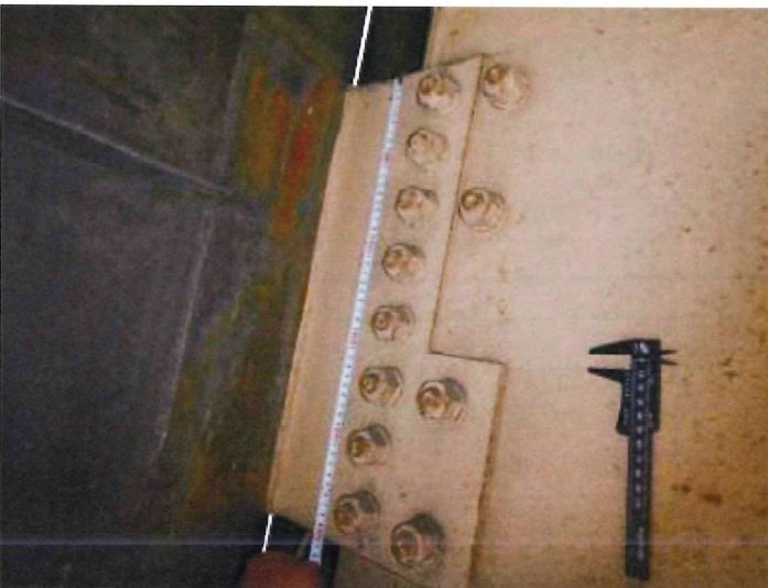
先端梁取り付けガセットサイズ測定状況
