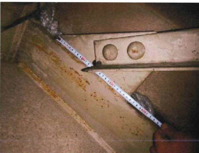
ブレースガセットサイズ測定状況
