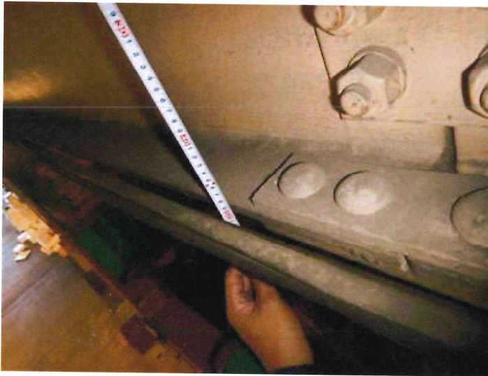
屋根ブレースサイズ測定状況
