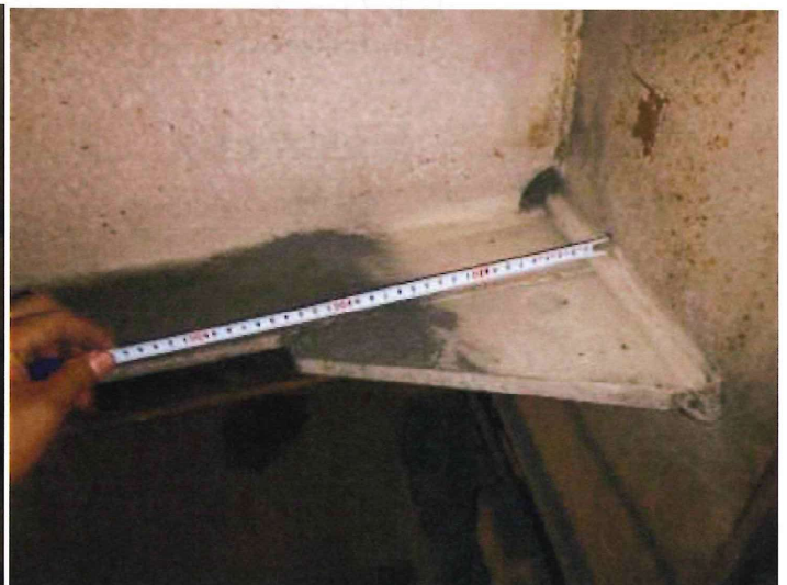
カバープレート厚測定状況
