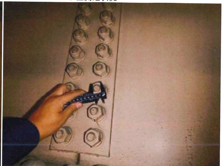
ボルト径測定状況
