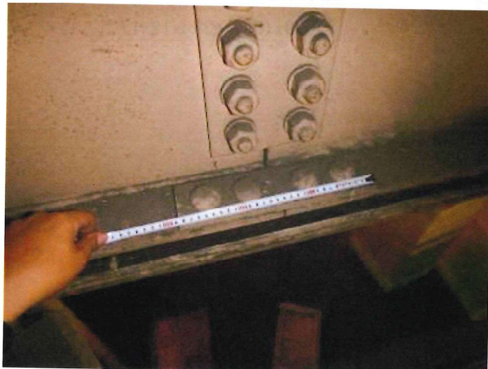
ボルトピッチ測定状況
