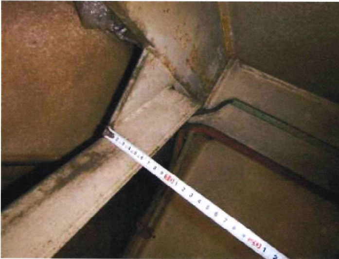
屋根ブレースサイズ測定状況
