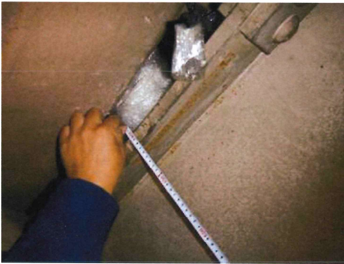
梁サイズ測定状況
