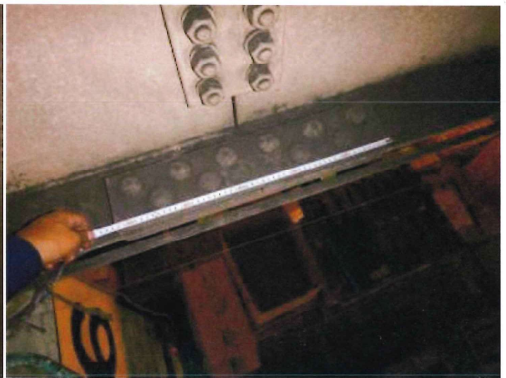
ボルトピッチ測定状況
