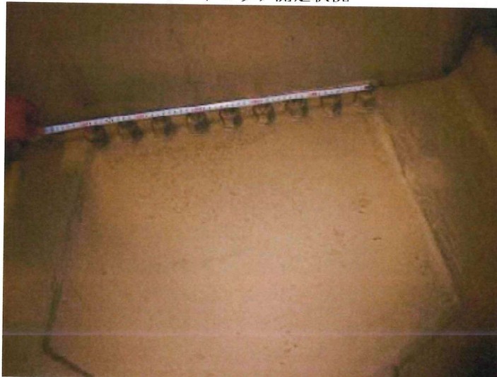
ボルトピッチ測定状況
