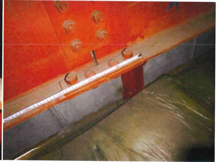
付けフランジ幅測定状況
