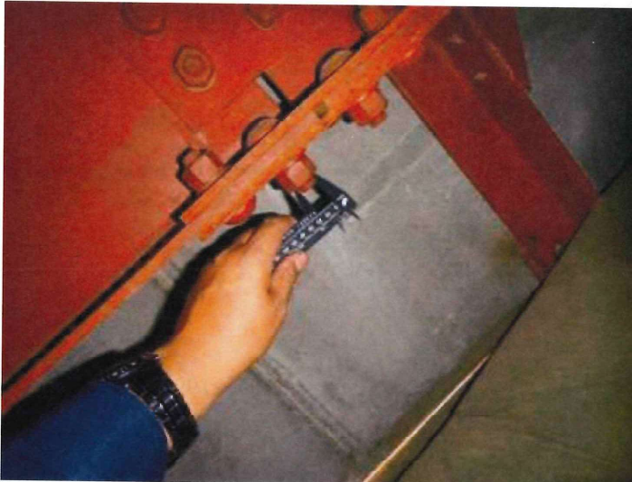
ブレースボルトピッチ測定状況
