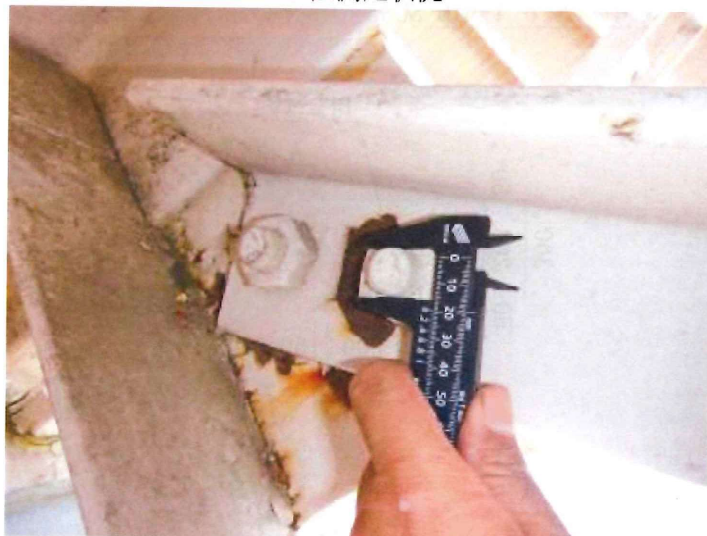
ボルト径測定状況
