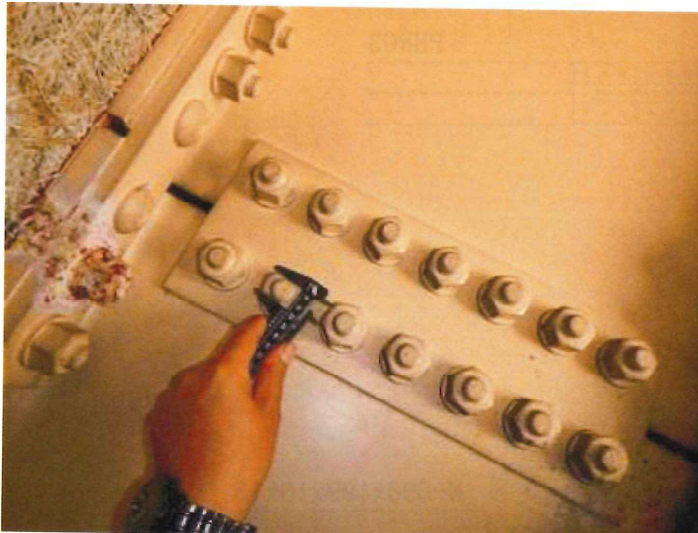
ボルト径測定状況
