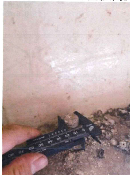
受水槽取り付けボルト径測定状況
