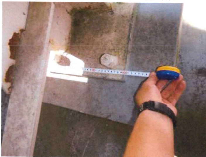
ベースプレートサイズ測定状況
