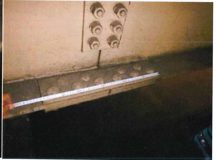
ボルトピッチ測定状況
