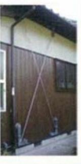
(参考)一般的な工法である「①筋かいで補強」とのコスト比較
