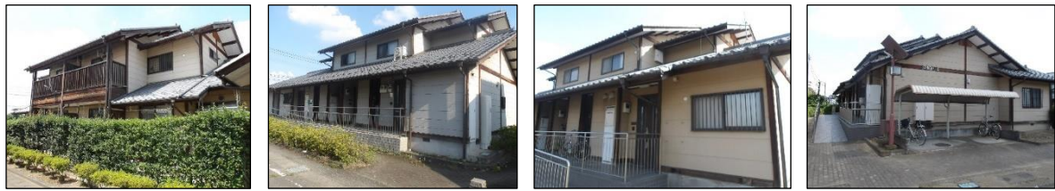
境上武士住宅(A~C棟)
