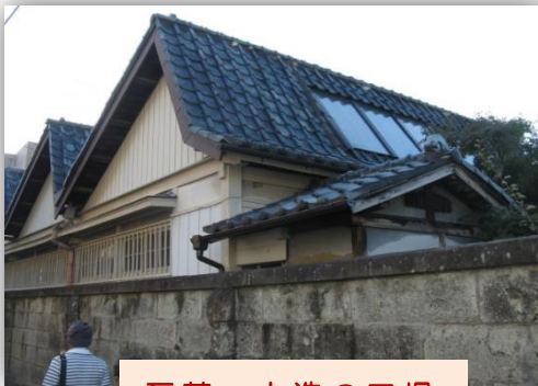
瓦葺・木造の工場
