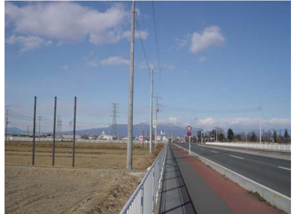
坂東大橋石山線
