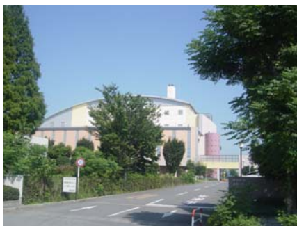
清掃リサイクルセンター21周辺 は山並みの眺望点となっている
