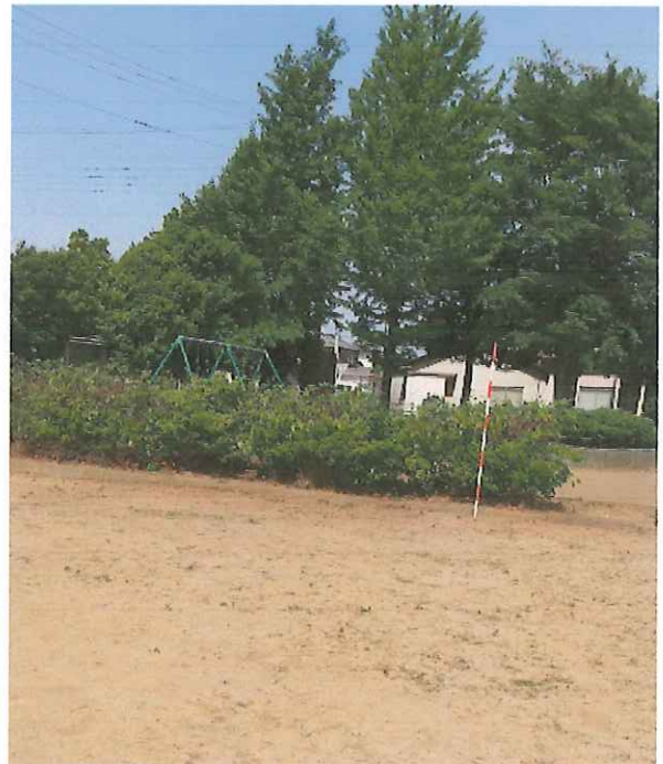
施工済み 高さ1.1~1.2m
