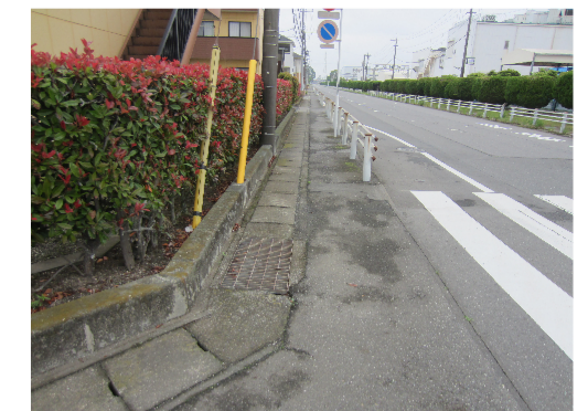
③ 既存道路の側溝改良 工事を実施します
