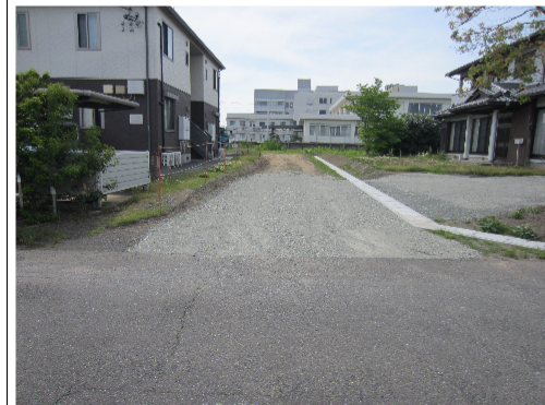
① 新設道路工事を 実施します
