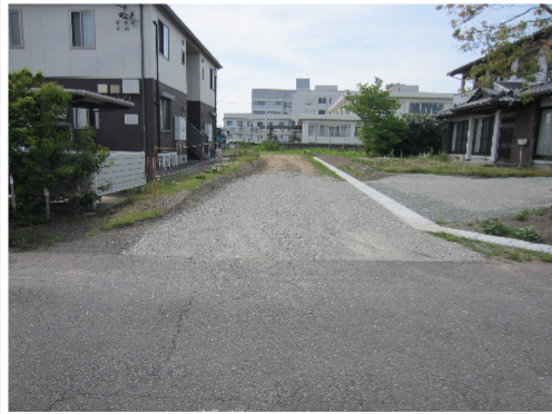
① 新設道路工事を 実施します
