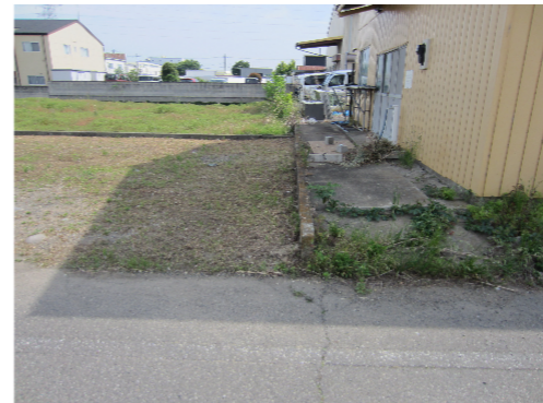
② 新設道路工事を 実施します
