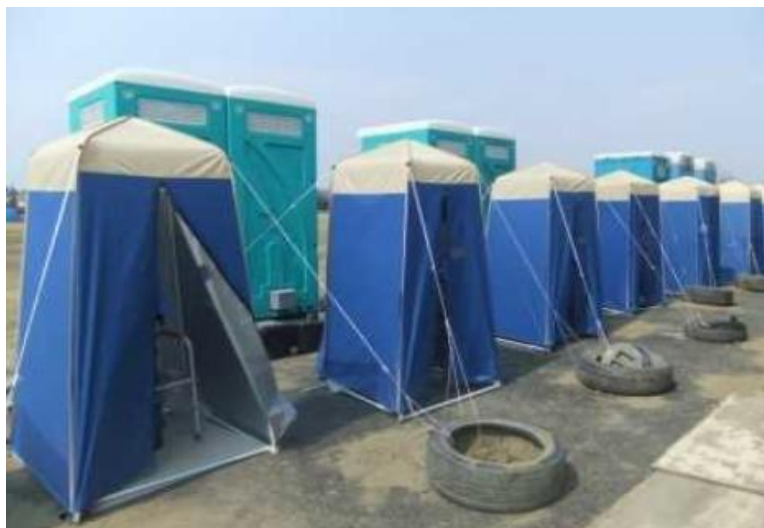
写真1 マンホールトイレ設置状況
