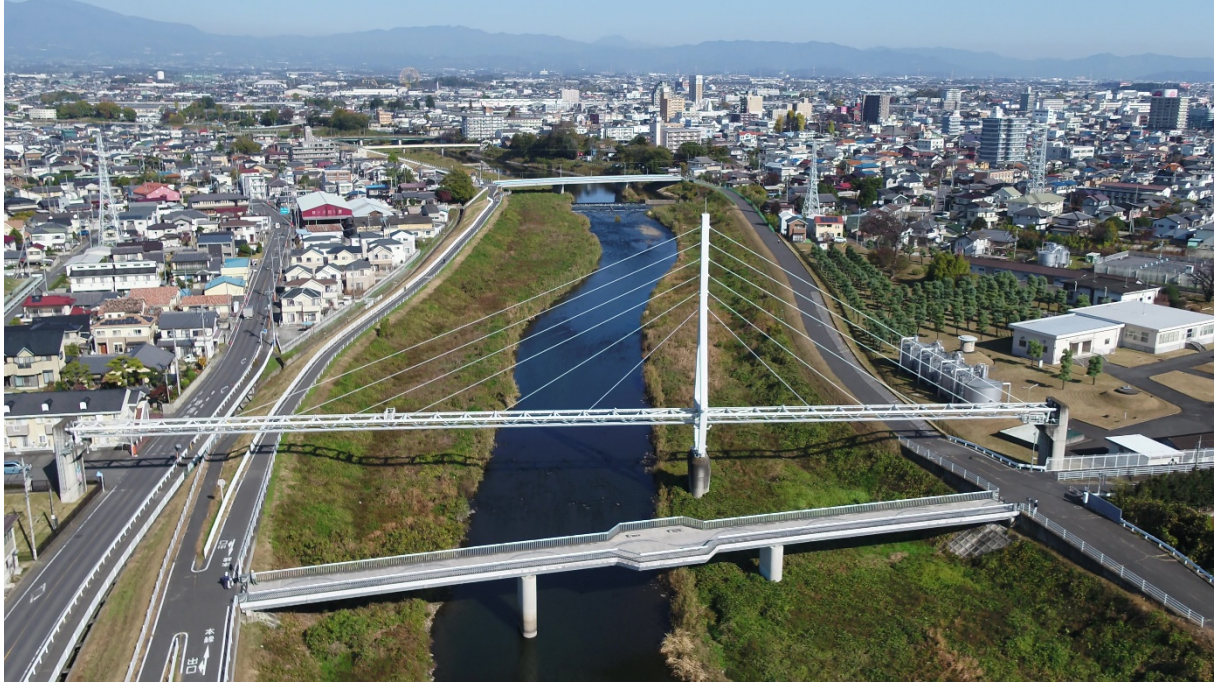
広瀬川に架かる水管橋
