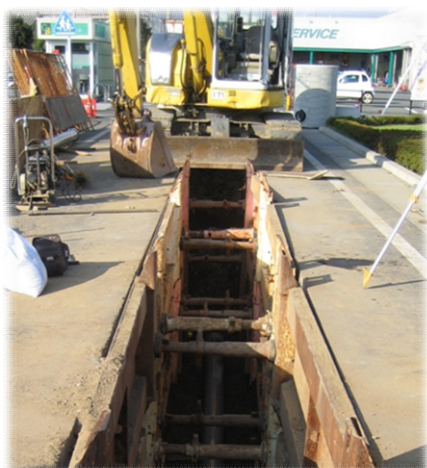
下水道整備（管きょ築造工事）
