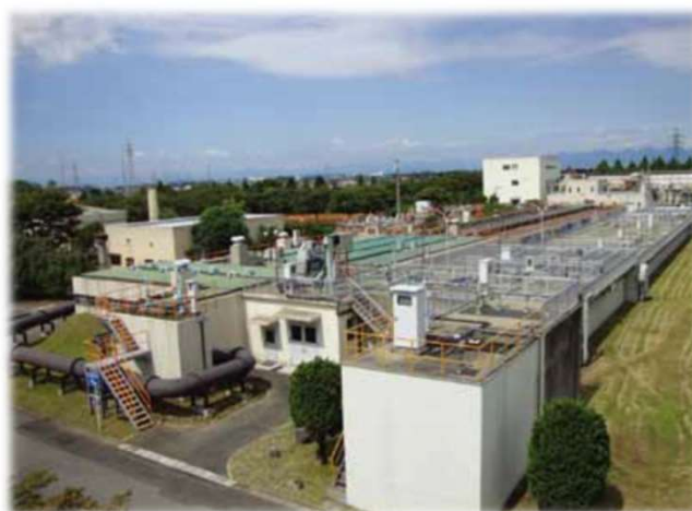
汚水処理場（伊勢崎浄化センター）
