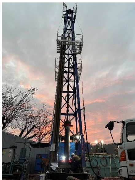
深井戸掘削状況(上泉水源地)
