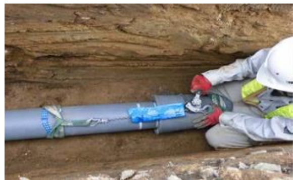
配水管布設状況
