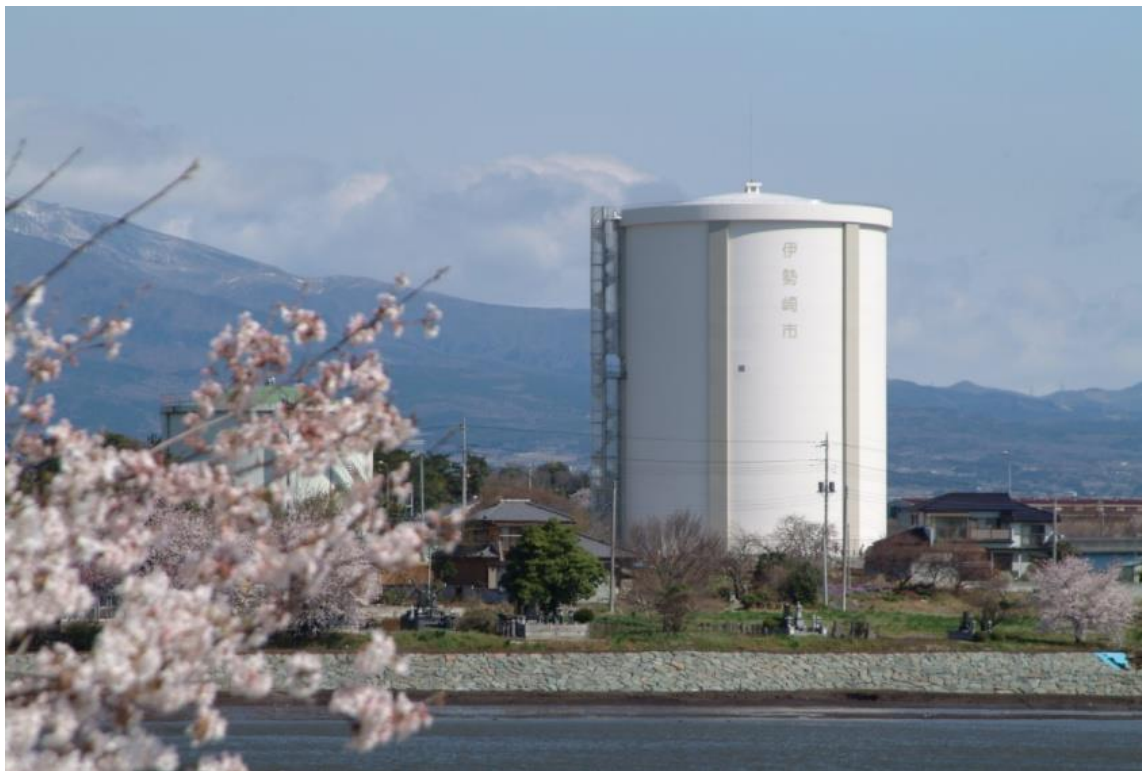
波志江配水場 配水塔
