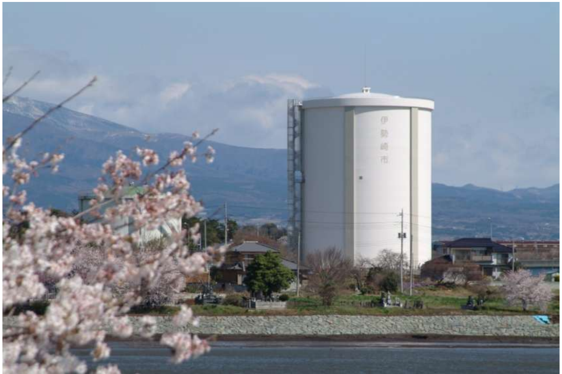
波志江配水場 配水塔
