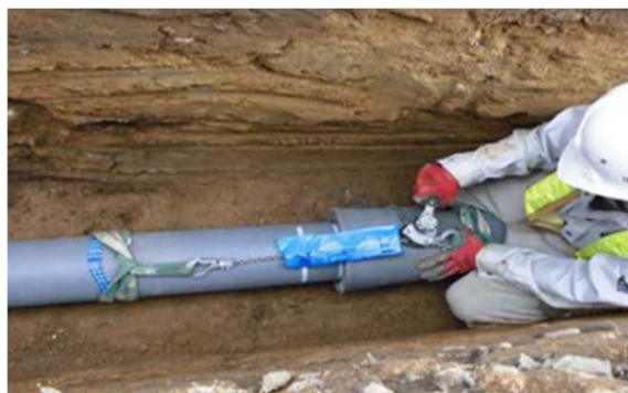
配水管布設状況
