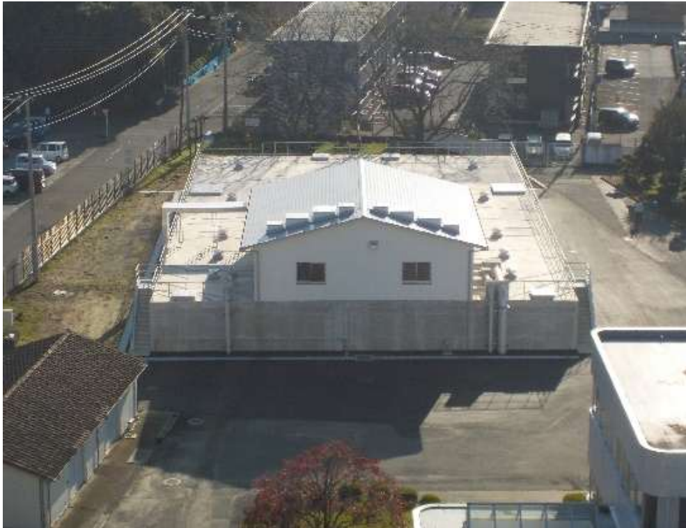
配水池(竜宮浄水場)
