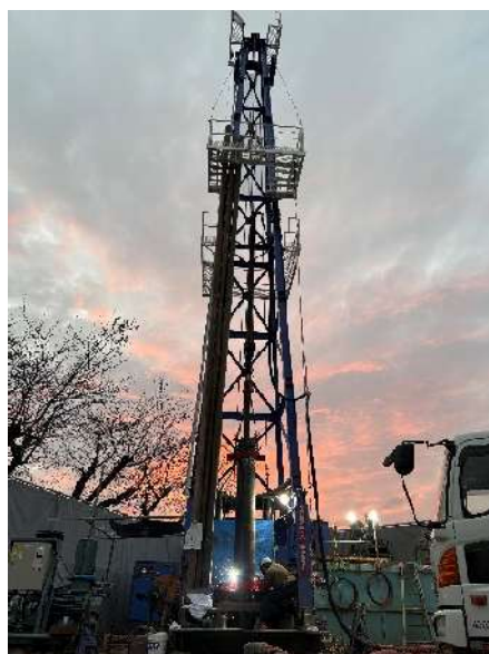
深井戸掘削状況(上泉水源地)
