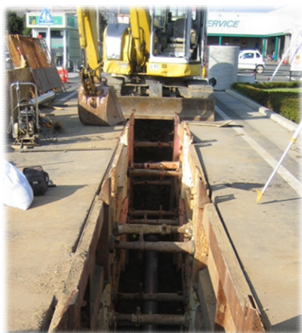
下水道整備（管きょ築造工事）
