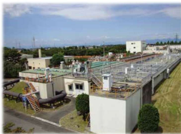
汚水処理場（伊勢崎浄化センター）
